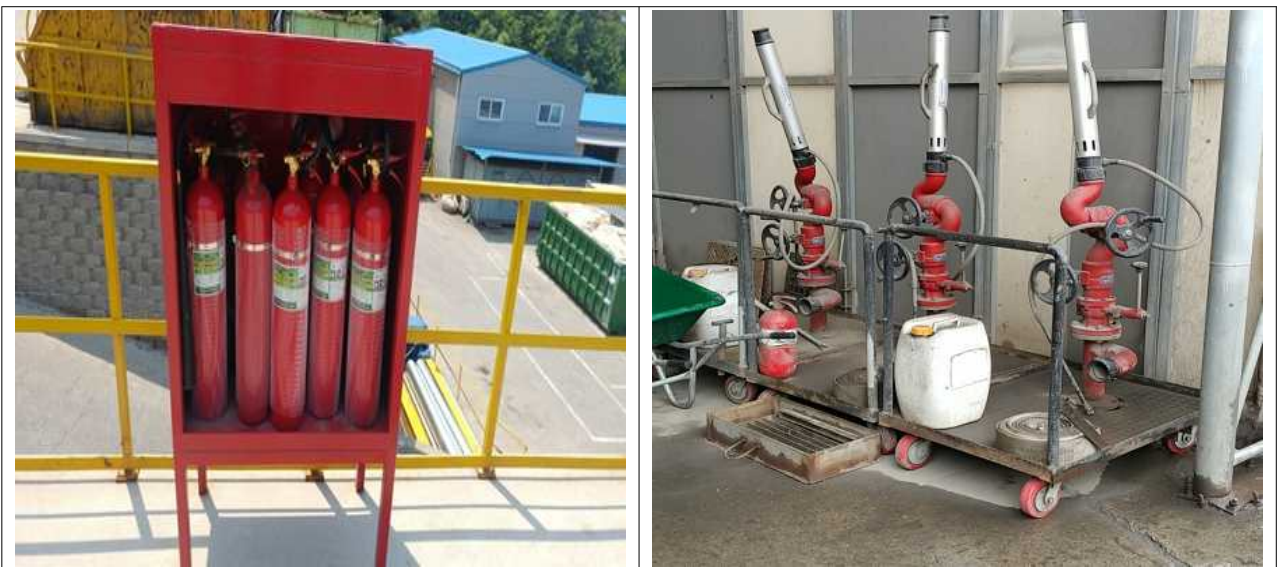
◆ 소각·매립업체 사업장 내 소화전 및 물대포 설치
